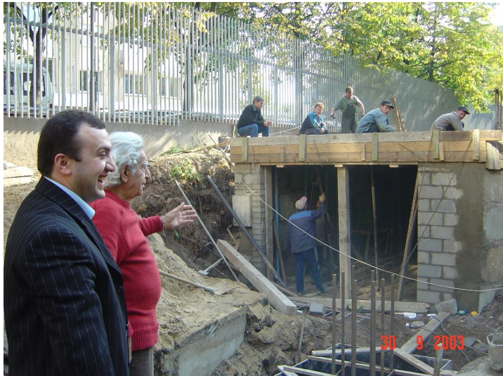
Строительство гаража для мастерской.
